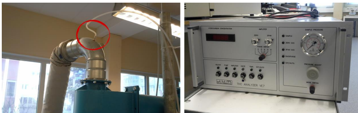
Figur 6. (a) Koppling av provtagningsledning.
